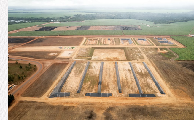
Construção da uisa Geo Biogás.
