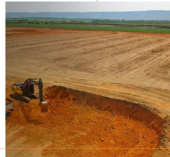
UISA GEO BIOGAS
