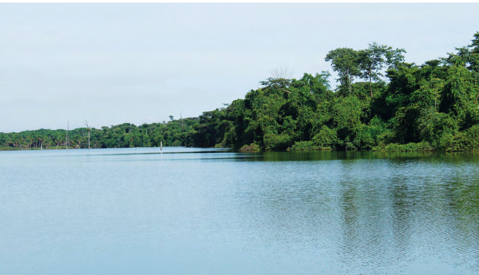
SÃO LOURENÇO DAM, IN UISA
