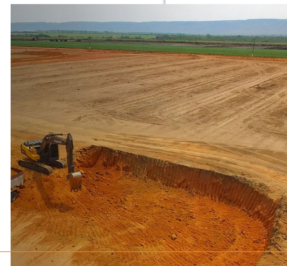
UISA GEO BIOGAS
