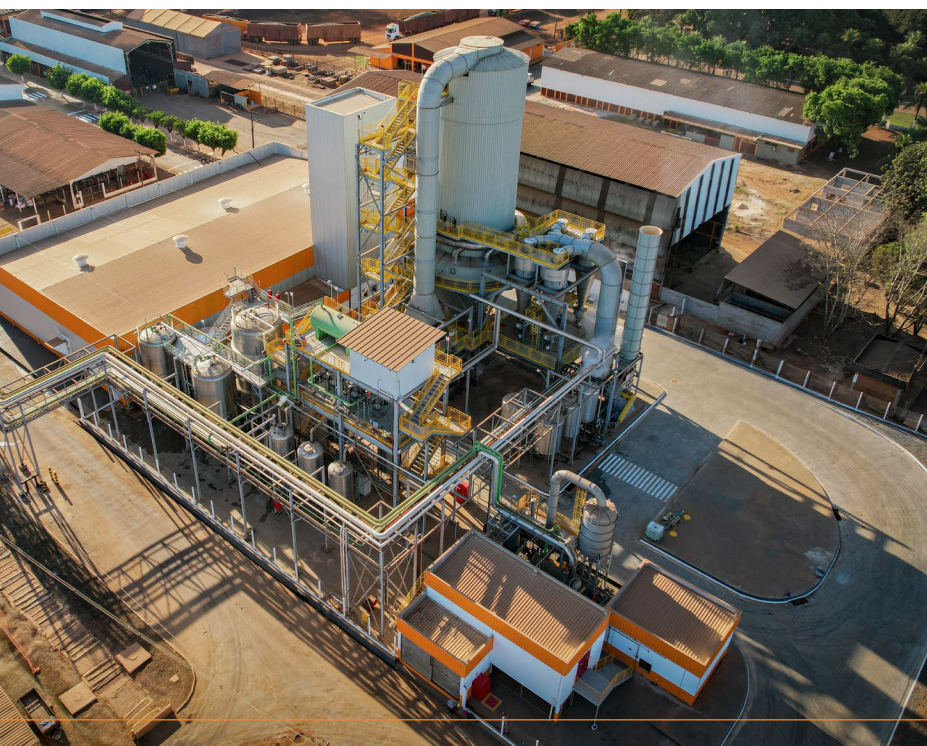
UISA BIONUTRITION, CONSTRUÇÃO CONCLUÍDA
